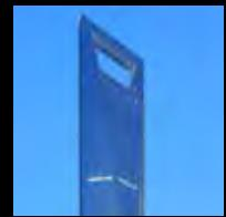
El edificio se construyó empleando secciones modulares que se repiten cada 13 pisos.
